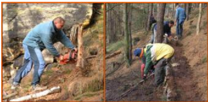
Dořezaly se pařezy a vybudovaly protierozní zábrany u cestičky pod skalami
